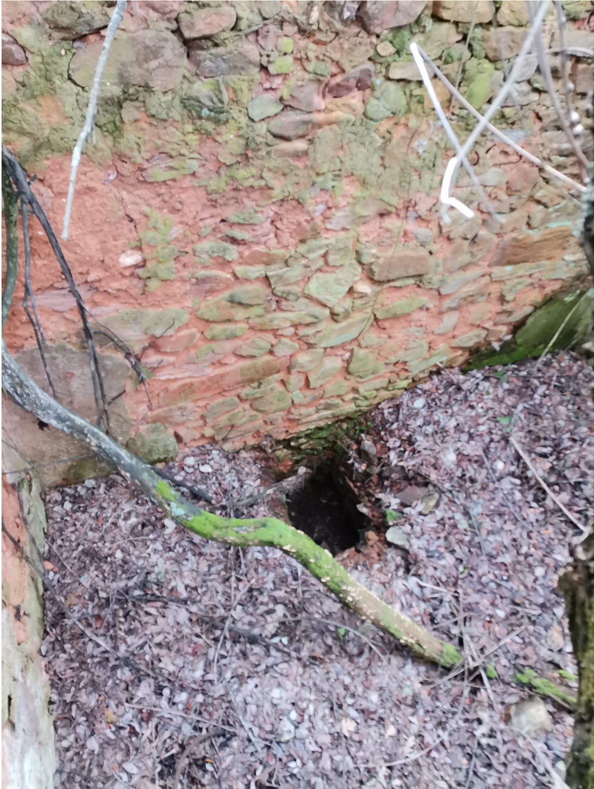
Restos de la antigua Tejera. Detalles de los muros, y del orificio para cargar la leña.
